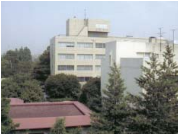
奥より国立国語研究所 1号館, 2号館, 3号館 (手前屋根) (2003年8月, 研究所南側団地から撮影)
