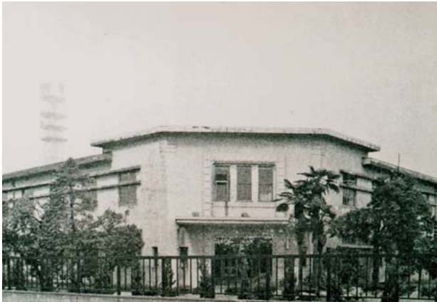
昭和37年4月～昭和51年11月：旧西が丘庁舎
